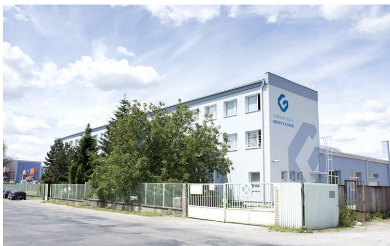
Obrázek č. 1: Budova SŠG na ulici Šmahova (foto vlastní/www.ssgbrno.cz)
