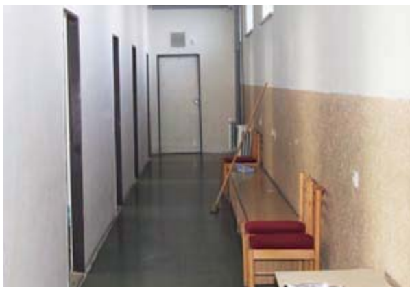
Počítačové učebny před rekonstrukcí
