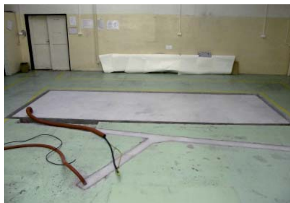
Vybudování betonového lože pro tiskový stroj
