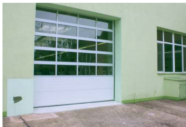
Instalace vratového křídla v ofsetové strojovně
